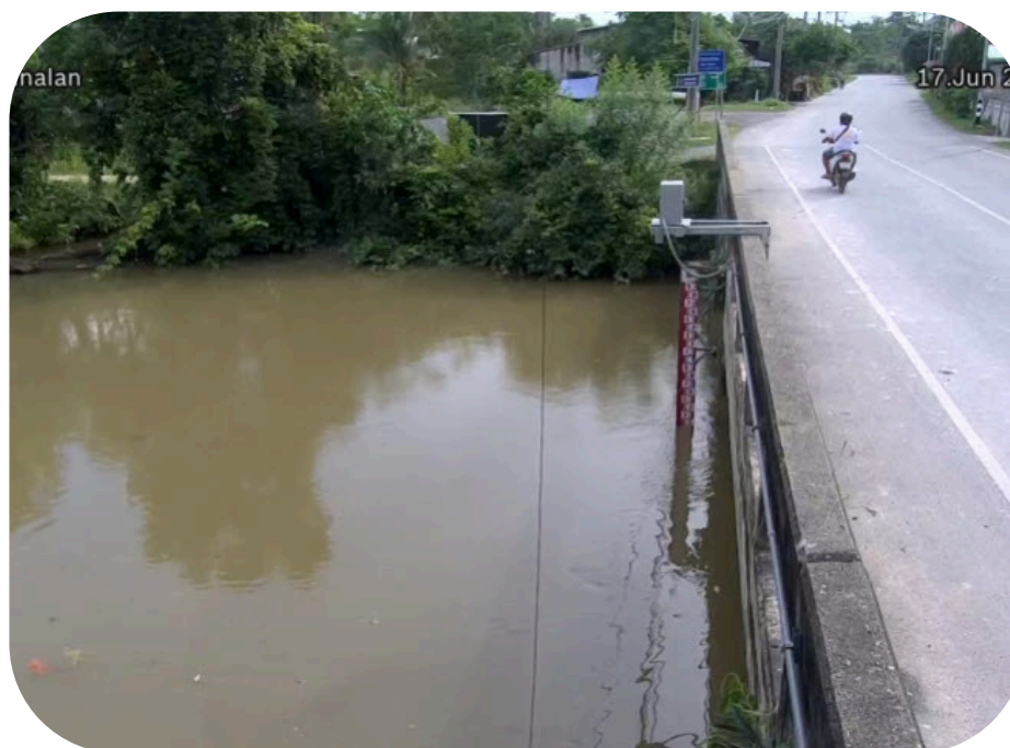
สะพานบ้านนาลาน อ.เมือง จ.สตูล
